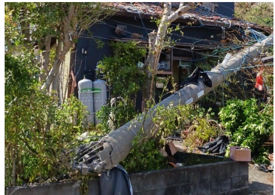
⑥ 電柱の折損（南東から北西に撮影）
