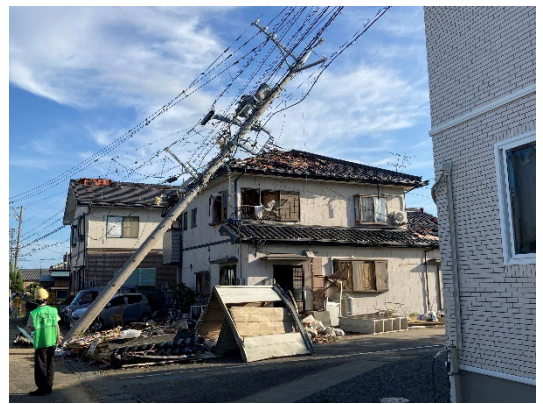
⑩ 電柱の折損（北から南に撮影）
