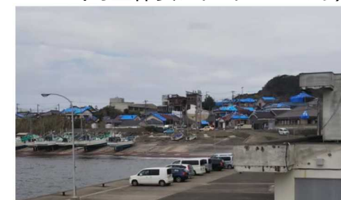
令和元年房総半島台風 （気象庁職員撮影） 16
