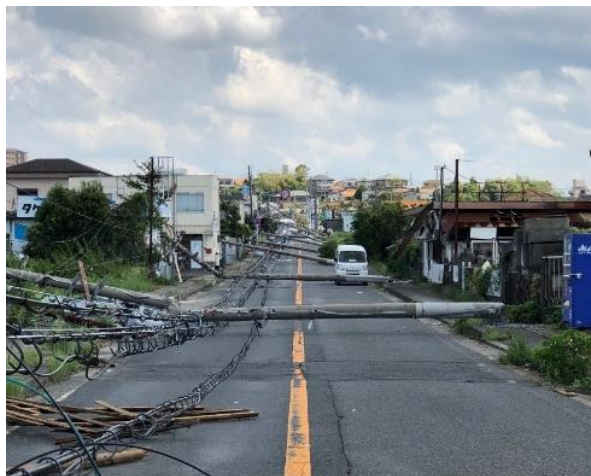
電柱倒壊
