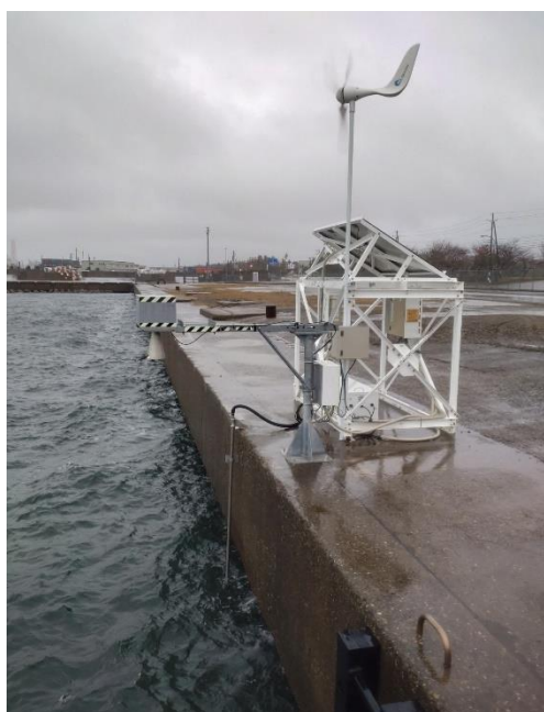
②電波式津波観測計の調整
