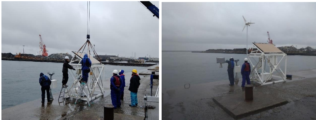
①設置作業の様子(左:太陽光パネル設置、右:組み立て)
