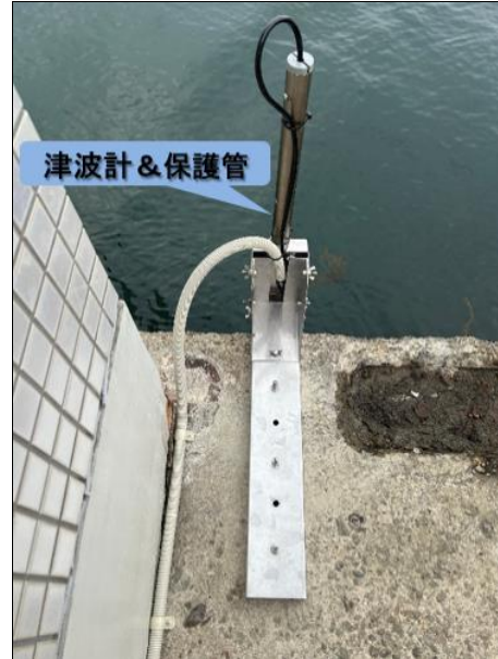
②岸壁への設置状況
