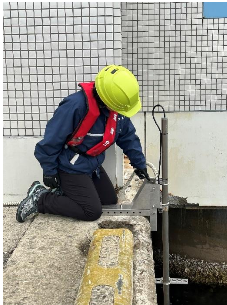
①組立作業の様子
