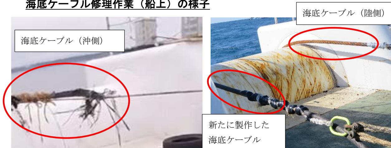
① 海底ケーブルの引き上げ
