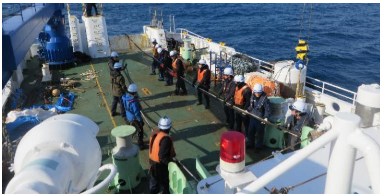
③ 海底ケーブルの再敷設作業
