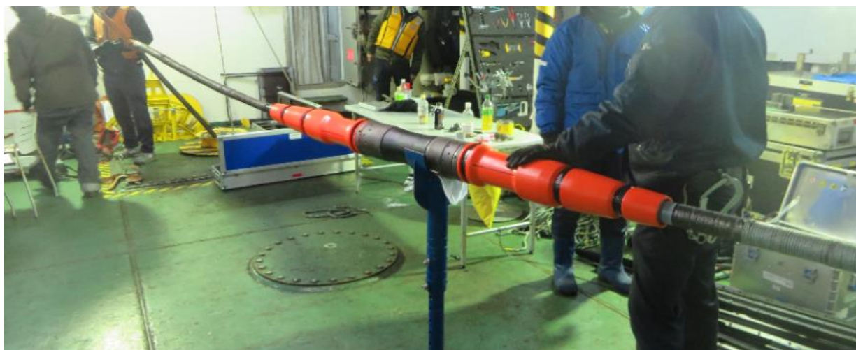
② 海底ケーブルの接続作業
