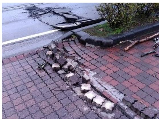
写真8-4：道路の亀裂及び段差
