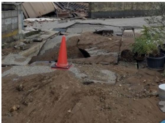
写真8-3：道路の陥没
