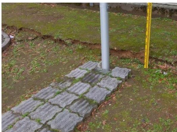
写真 8 - 10 : 地面のひび割れ及び段差
