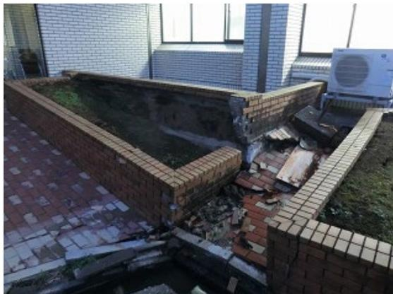
写真8-6：地盤の陥没
