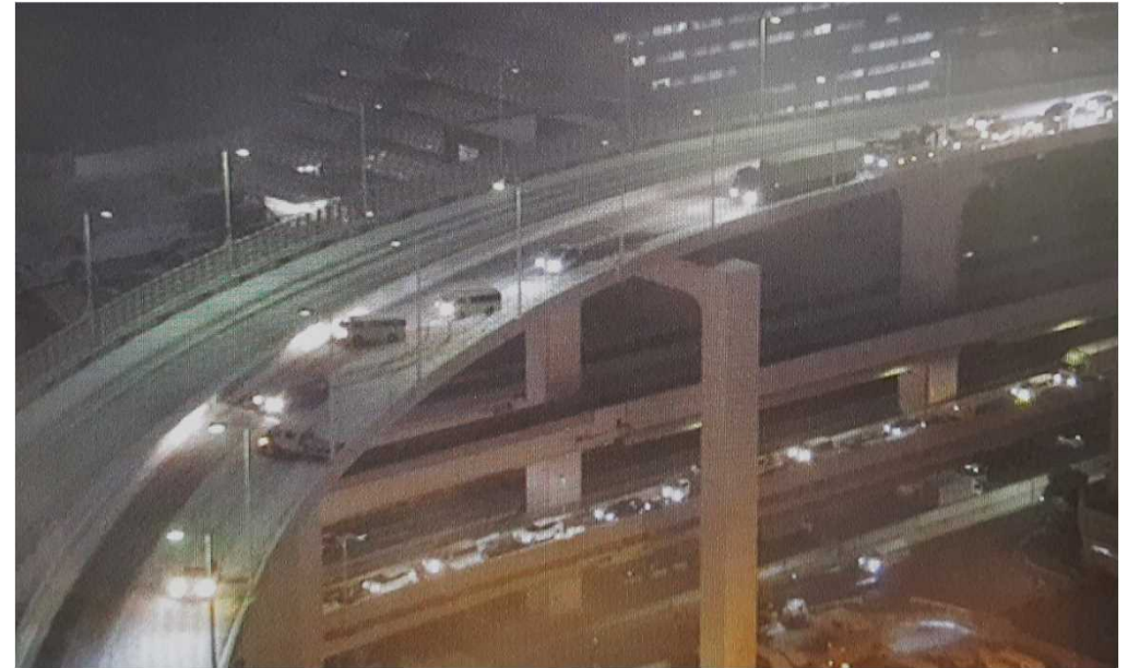
車両の滞留 ＜首都高速道路 台場線＞
