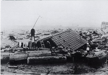
名古屋市南区の被害と材木で壊れた住宅 (伊勢湾台風50年事業実行委員会)
