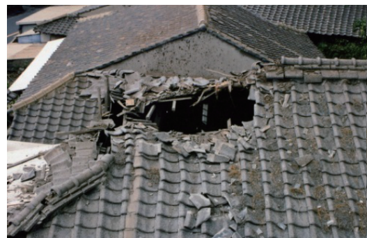
噴火で噴出した噴石で穴が開いた瓦屋根
