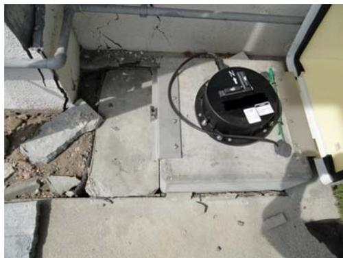
震度計台周辺の庁舎及びコンクリートに亀裂
