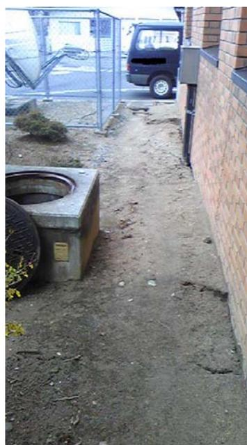
震度計台と庁舎間の地盤が陥没し、震度計台が南側（上方方向）に傾いた。
