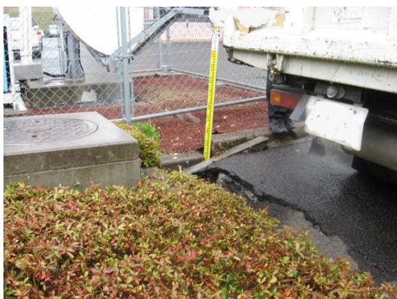
震度計台が設置された植え込み側の地盤が、西側（右方向）のアスファルト面に対して下がり、段差ができた。震度計台が東側（左方向）に傾いた。
