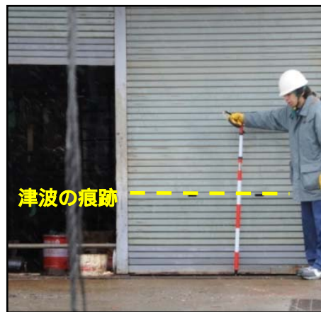
床上浸水した事業所
