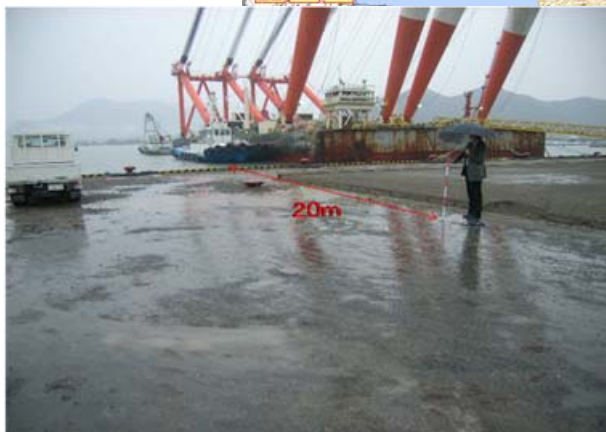
須崎港串の浦地区の浸水の痕跡
