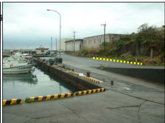
岸壁の雑草付近まで冠水
