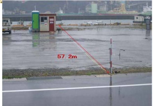
大間地区船置き場付近の浸水の痕跡
