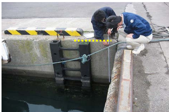
大洗港の岸壁上端から約 25cm 下に变色あり。
