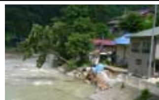
新潟・福島豪雨による土手の崩壊 (平成16年7月: 福島県)
