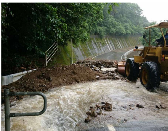
国道441号線(野村町溪筋)
