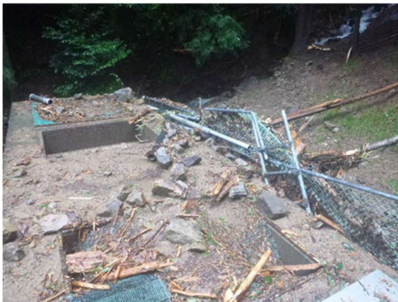
簡易水道浄水場(城川町高野子)
