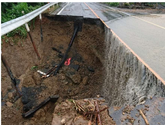
光通信ケーブル(野村町河西)
