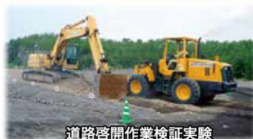
道路啓開作業検証実験
