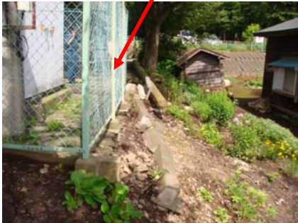
写真1 震度計台付近斜面
