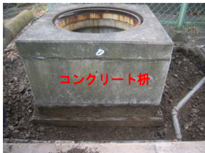
写真3 北西断面側開削終了
