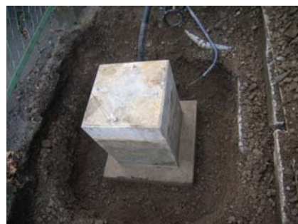
写真6 震度計台周囲開削終了後
