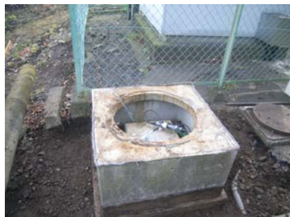
写真4 コンクリート枡の蓋撤去
