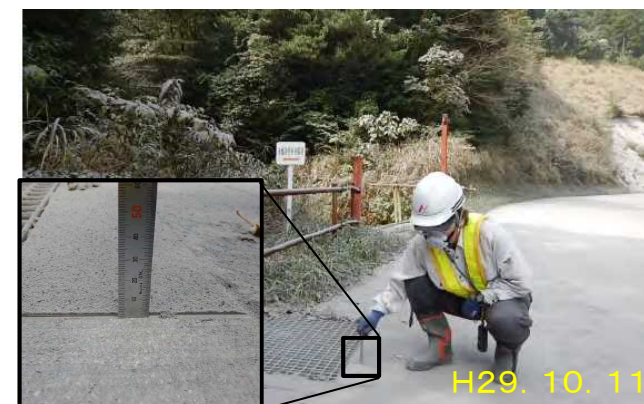
地上からの現地調査状況
