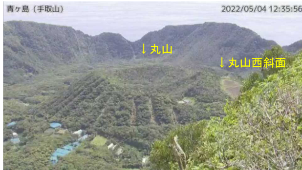
① 丸山周辺の状況（5月4日 手取山監視カメラ）
