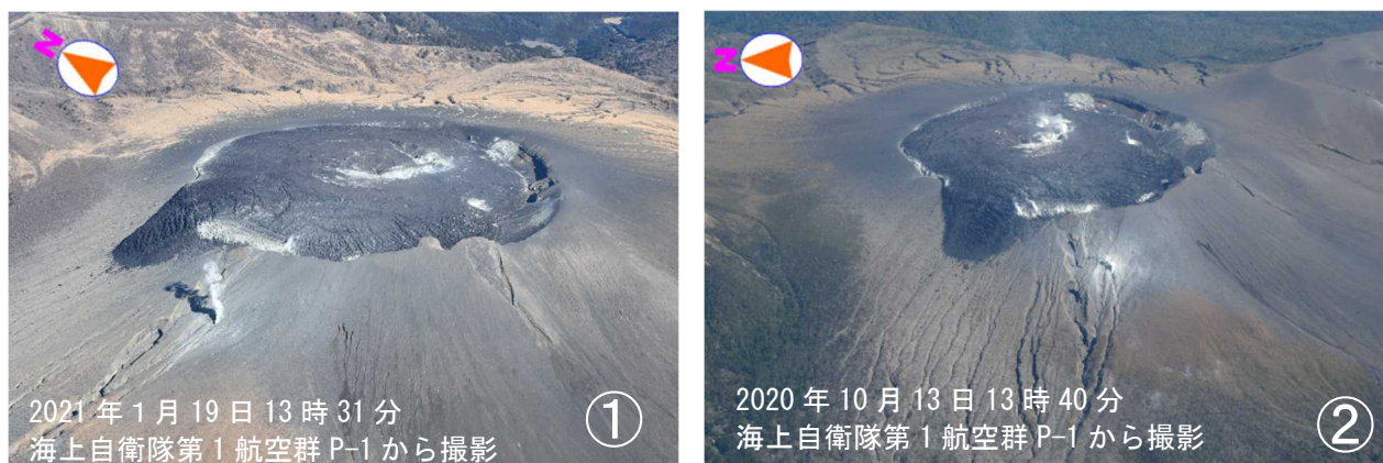
図1 霧島山（新燃岳） 新燃岳火口周辺および西側斜面の状況
