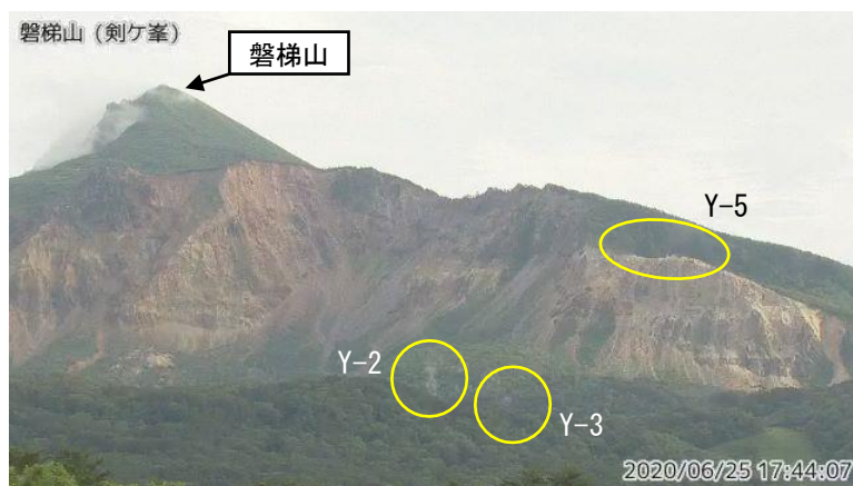
図 1 磐梯山 山体北側火口壁の噴気の状況（6 月 25 日）
