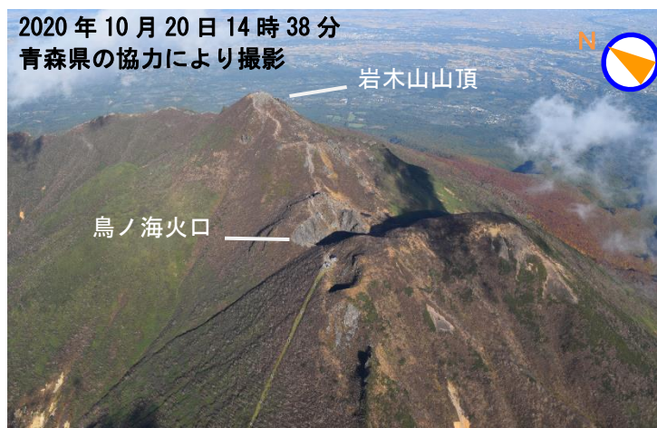
図 3 岩木山 上空から撮影した山頂部の状況
