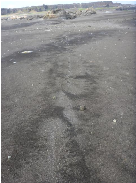
図 12 噴出孔 A 南側の雁行割れ目 (2 月 18 日) 北西-南東走向だが例外的に左横ずれを示す。
