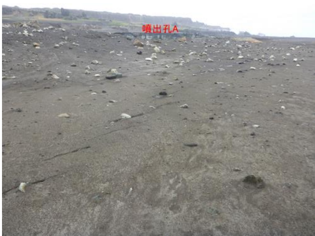
図10 噴出孔A南東側の雁行割れ目(2月18日) 北西-南東走向で右横ずれを示す。
