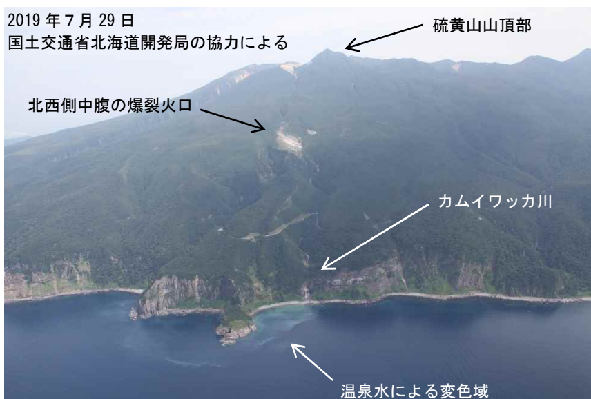
図 2 知床硫黄山 北西側からみた山体および海岸付近の状況
