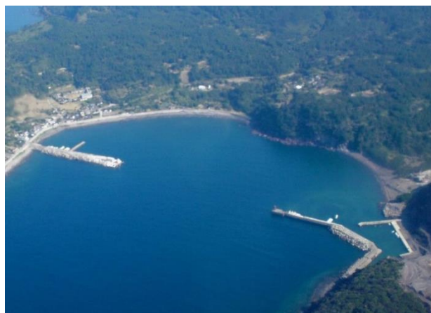
平常時の口永良部漁港の状況 2009 年 2 月 5 日撮影
