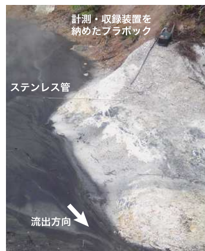
写真1. エアー管と収録装置の設置状況。エアー管は耐腐食性を考慮し、熱水内に沈める部分はステンレス管(SUS316, 8A)とし、このステンレス管と計測・集力装置はテフロンチューブでつないでいる
