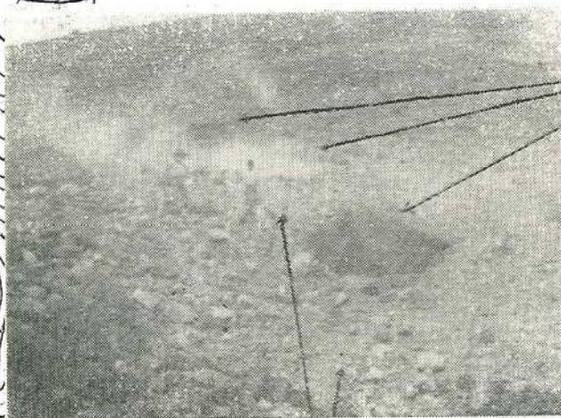
左図の A 点の状況 上の三本の矢印は噴出の穴 下の二本の矢印は亀裂の線
