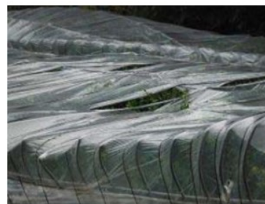
不知火ハウスの損壊 (熊本県芦北町：平成28年1月)
