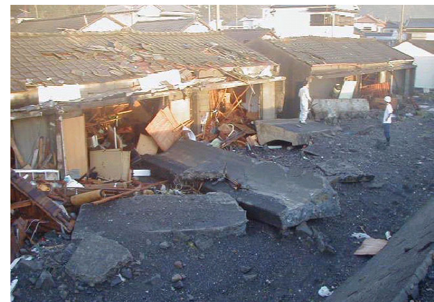
平成16年台風第23号による高波被害 (高知県室戸市菜生海岸)
