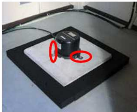
【 アンカーボルトによる固定 】
