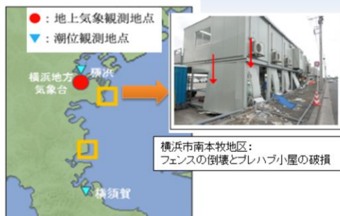
図5.1.5 横浜市臨海部での現地調査地点(橙枠)と被害写真 (出典:横浜地方気象台, 東京管区気象台(2019))
