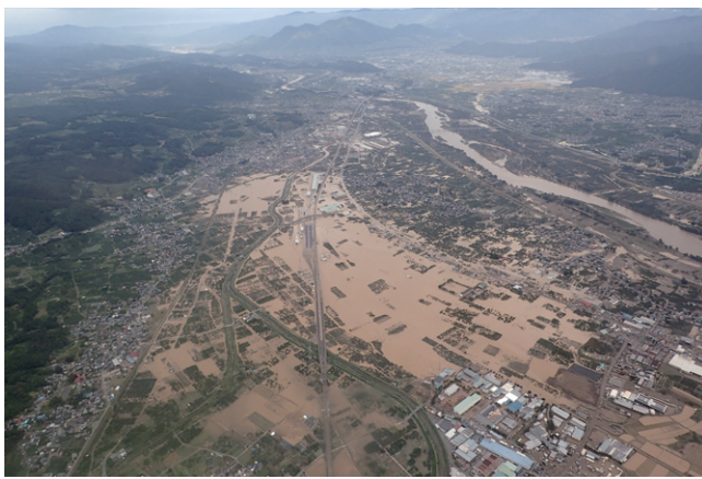
千曲川堤防決壊による浸水状況（長野県長野市） （写真：北陸地方整備局提供）
