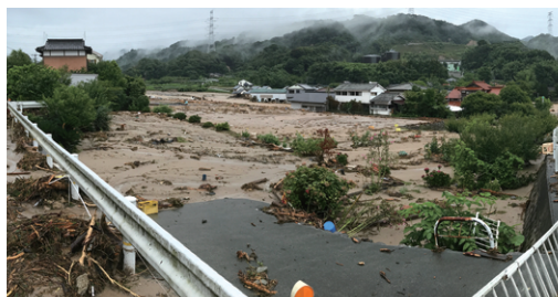
福岡県朝倉市の浸水状況 (写真：気象庁職員撮影)
