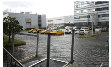
関西国際空港の浸水 (気象庁職員撮影)
