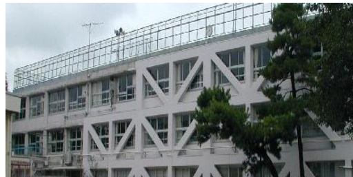
学校の耐震化(世田谷区HPより)
