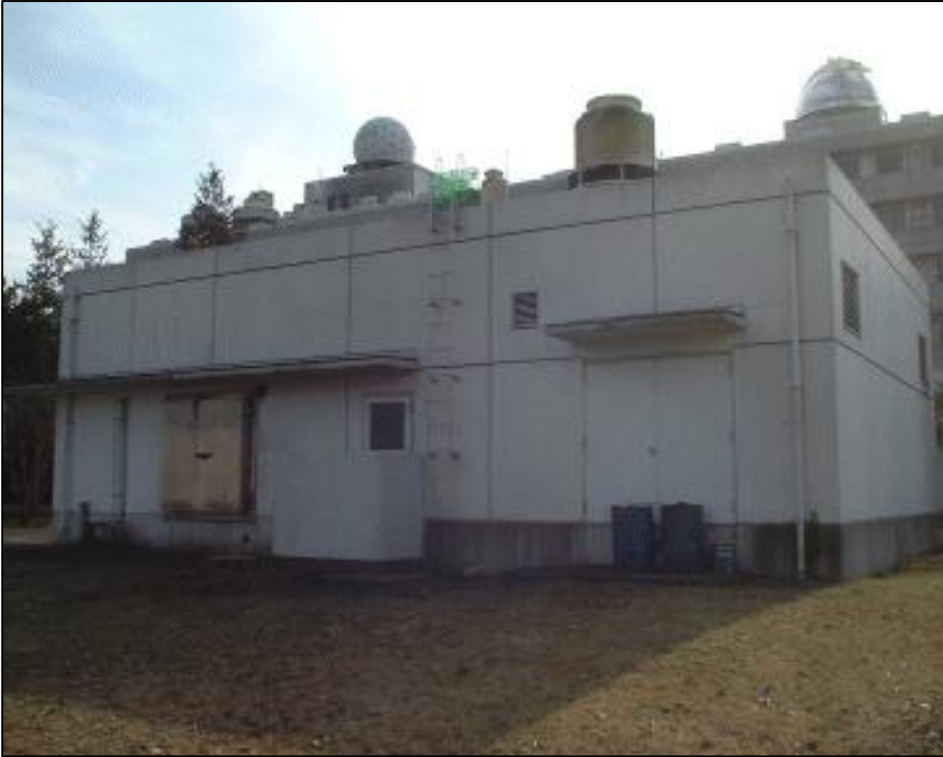
図 7-2-2 平成14年改修前の低温実験棟全景
