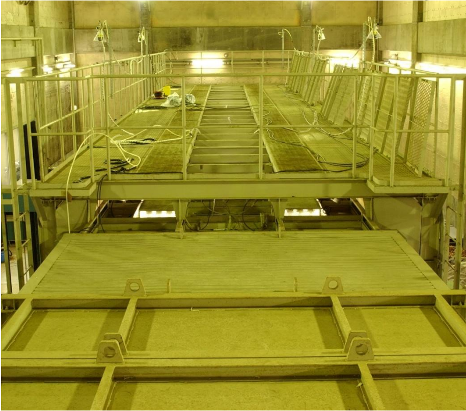
図 7-2-10 測定胴天井（平成19年）
