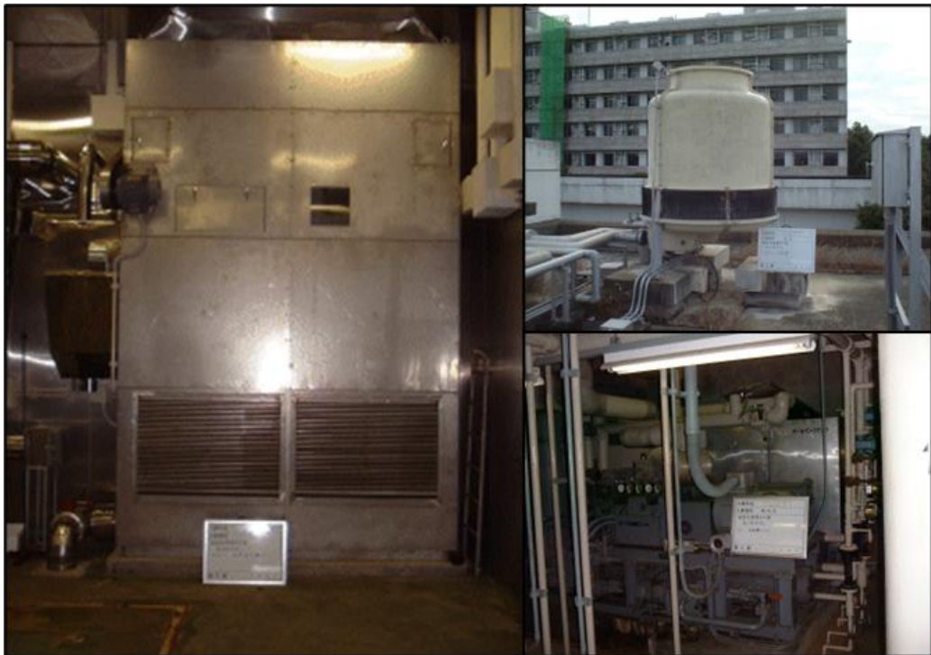
図 7-2-3 ・平成14年改修前の-30℃低温室の室内（左） ・冷却塔（屋上）（右上） ・水冷式スクリー冷却機（機械室）（右下）
