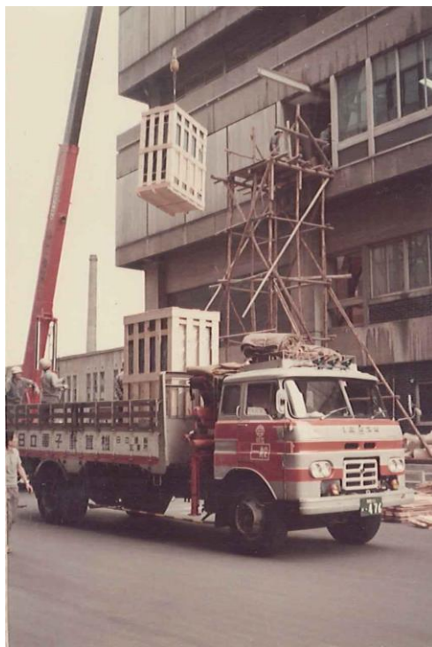
図 4-1-21 搬入作業の様子
