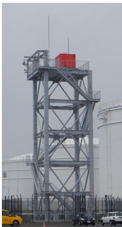
図 3-2-30 第二世代LIDAR （羽田空港2号機）
