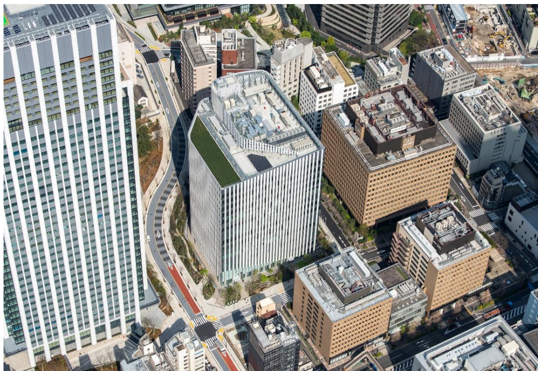
図 1-2-11 虎ノ門庁舎完成（航空写真）
