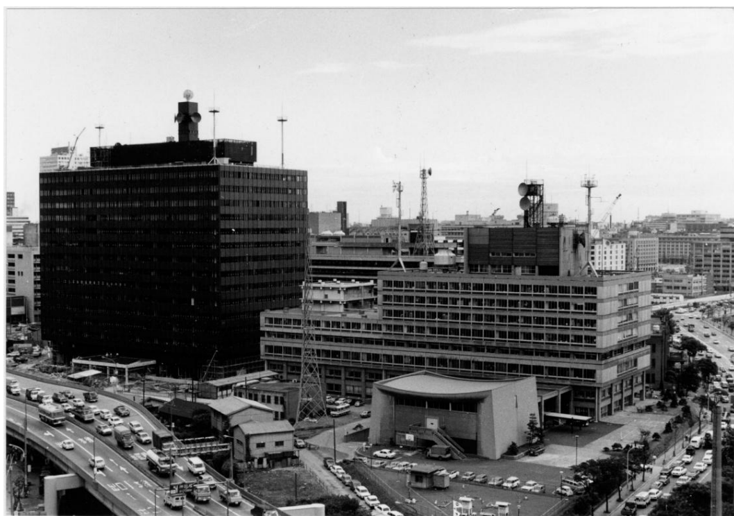
図 1-2-8 庁舎北側、別館 昭和45年ごろ（増築前）
