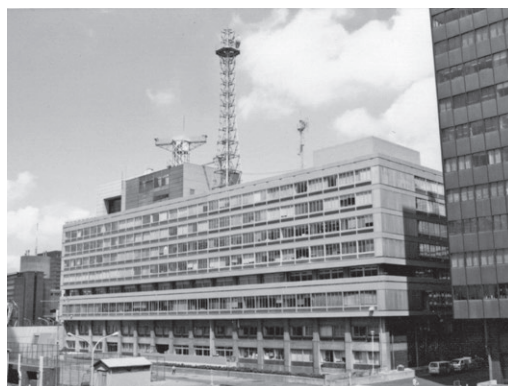
図 1-3-2-2 昭和 57 年 庁舎増築工事後
