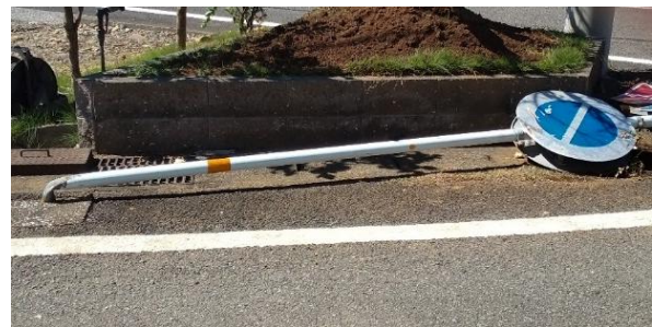
支柱が倒壊した道路交通標識 (④8月28日 宮崎県宮崎市)
