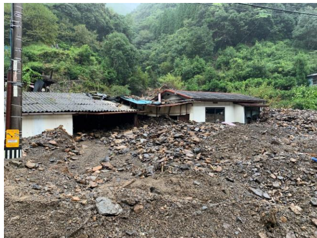
宮崎県西米良村の土砂災害 (9/19撮影 宮崎県砂防課提供)
