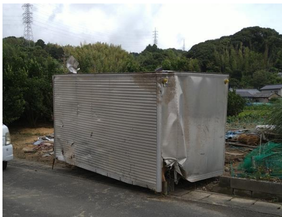
横転、移動した物置（固定なし） （9月18日 静岡県牧之原市：②）
