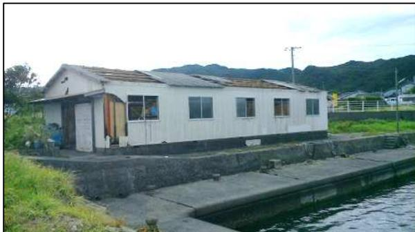
屋根のトタンが飛散した非住家(8/22 千葉県南房総市)
