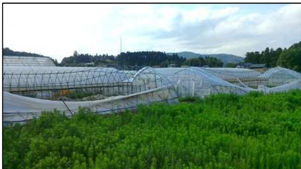
鋼管が変形したパイプハウス(8/22 宮城県亶理郡亶理町)
