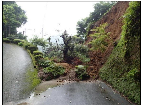
鹿児島県霧島市の道路法面崩壊 (提供：霧島市)
