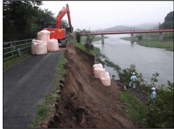
山口県岩国市島田川の堤防法面崩壊 (提供：岩国市)
