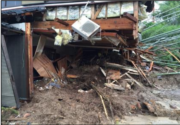
熊本県熊本市北区津浦町の土砂災害被災家屋 (提供：熊本市危機管理防災総室)
