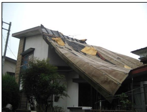
トタン屋根がめくれた住家 (7/14 埼玉県児玉郡上里町)
