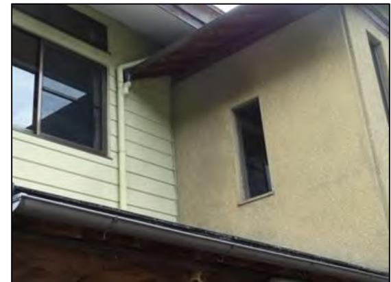
写真 3 役場西の建物に外壁のずれ、階段及び室内廊下の歪み
