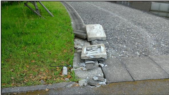
写真3 役場側溝蓋の破損(嘉島町上島)
