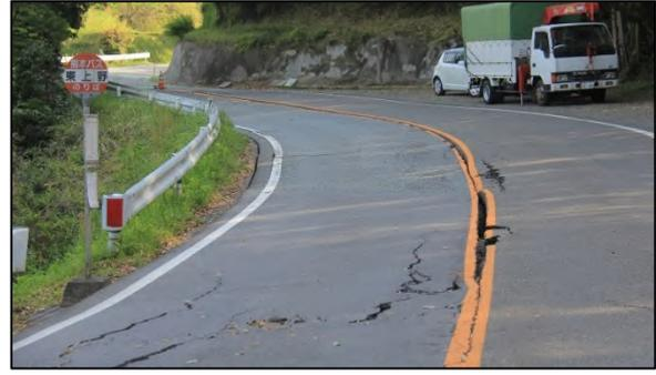
写真2 道路に発生した亀裂
