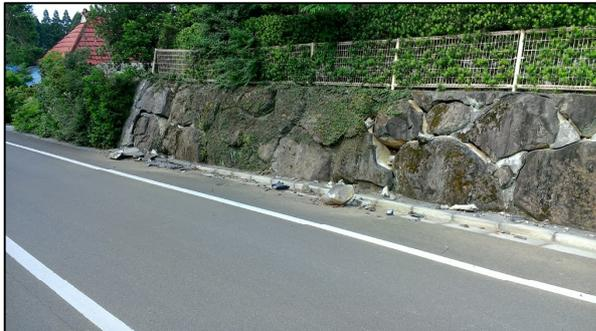
写真8 石垣の亀裂 (宇城市豊野町下郷)
