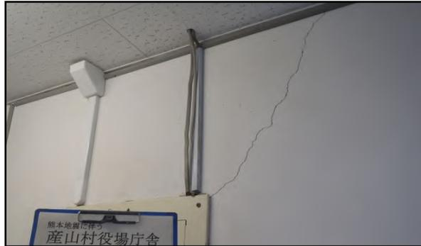
写真3 庁舎内壁の亀裂
