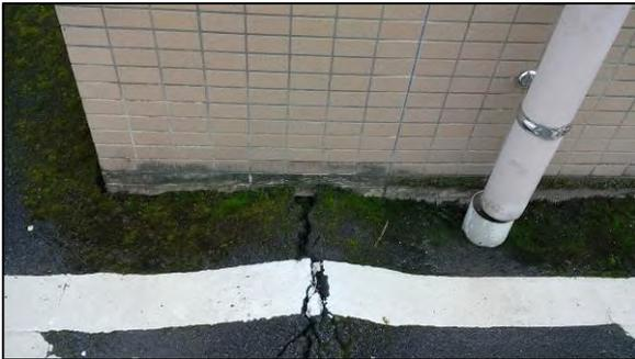
写真 16 歩道の亀裂(熊本市南区富合町清藤)
