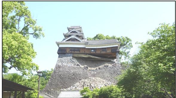
写真4 熊本城石垣の損壊(熊本市中央区本丸)
