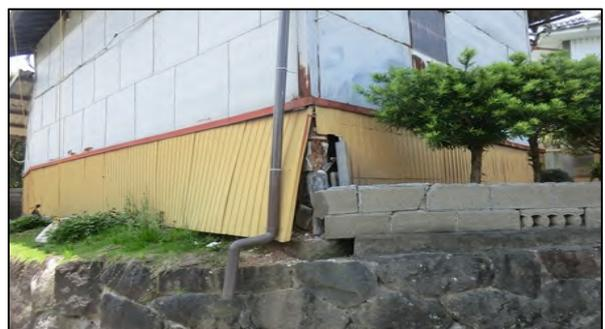
写真4 民家の壁の剥離、ブロック塀の亀裂（大津町引水）
