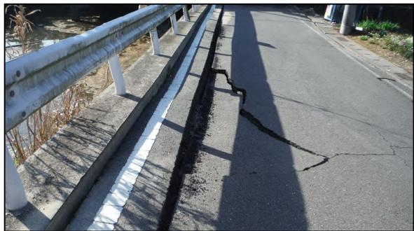
写真8 路面の亀裂、陥没
