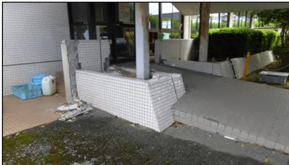
写真 15 支所の壁のタイル剥離
