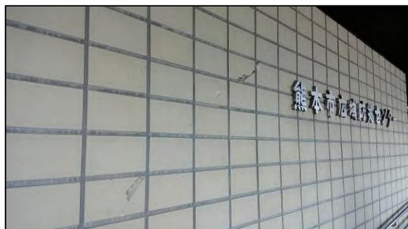
写真7 消防局の壁面の亀裂
