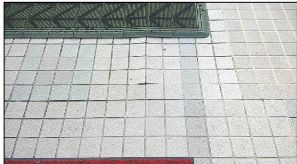
写真2 外庭タイルの破損(合志市竹迫)
