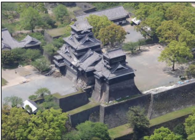
写真3 熊本城石垣の損壊、屋根瓦の破損
