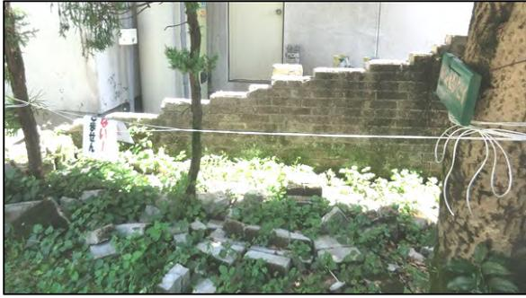
写真4 ブロック塀倒壊(菊池市泗水町豊水)
