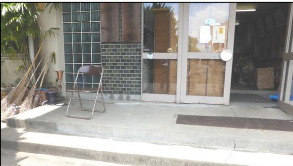
写真5 通路の亀裂、玄関ガラス損壊
