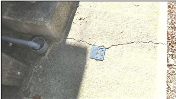
写真 21 施設犬走りに亀裂 (植木町岩野)
