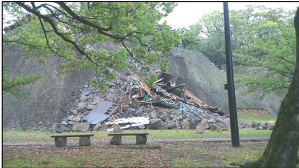
写真3 熊本城石垣の損壊(熊本市中央区本丸)
