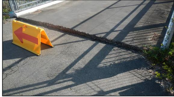
写真2 橋の上下ずれ(反対側)(和水町原口)
