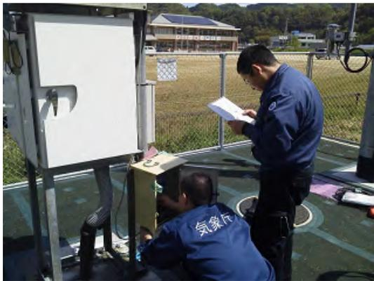
i-SENSOR 可搬型雨量計設置作業
