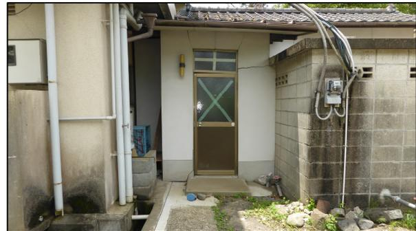
写真6 建物傾倒、壁と通路の亀裂
