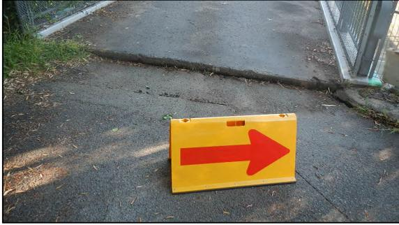
写真1 橋の上下ずれ(和水町原口)
