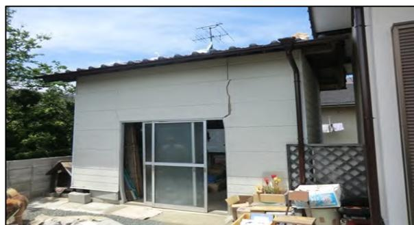
写真3 民家の壁の亀裂（大津町引水）
