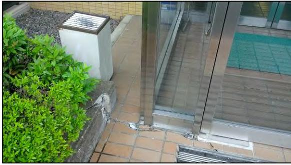
写真 12 地面の亀裂
