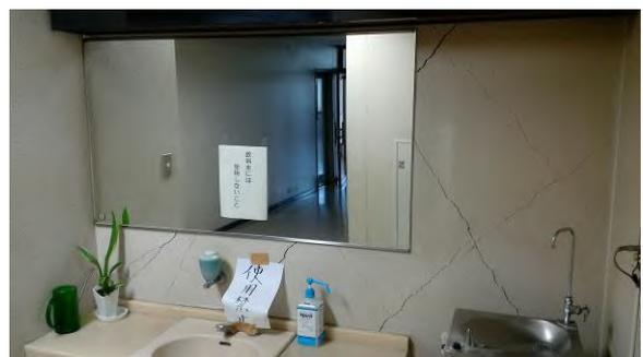
写真8 消防局の壁面の亀裂
