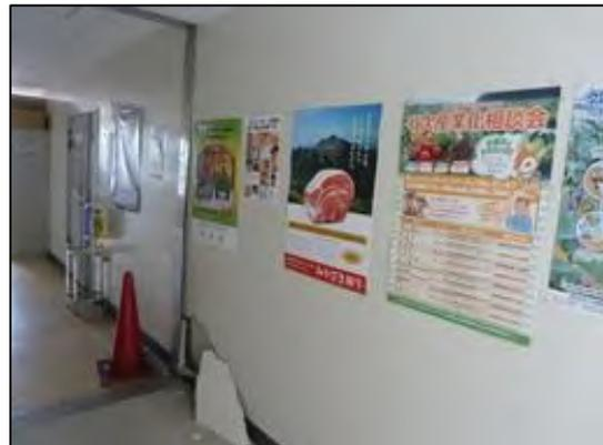
写真 1 美郷町役場 2 階の状況（内壁の亀裂及び一部剥離、つなぎ目の変形剥離）
