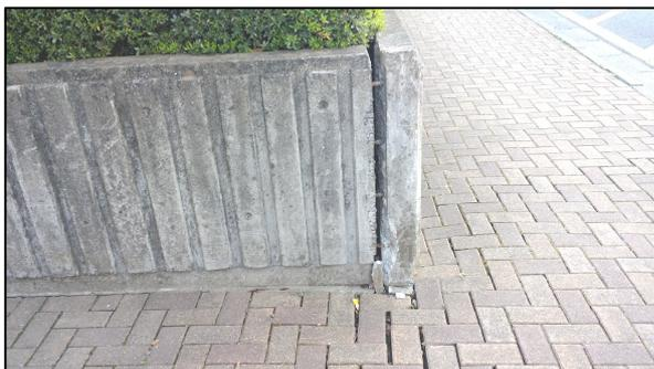
写真3 植栽壁の破損(合志市竹迫)
