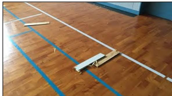
写真 2 スポーツ施設天井部材落下
