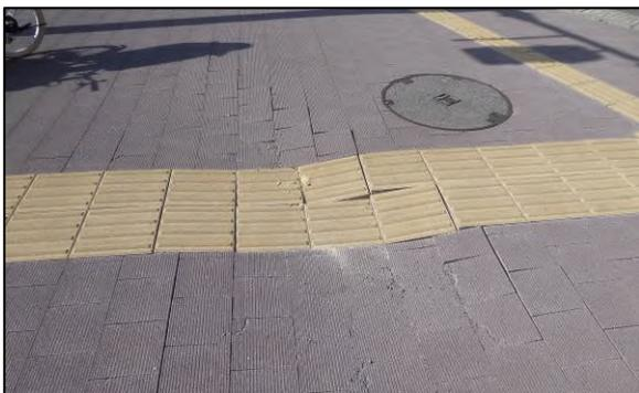
写真 9 道路の亀裂、陥没(熊本市西区田崎一丁目)
