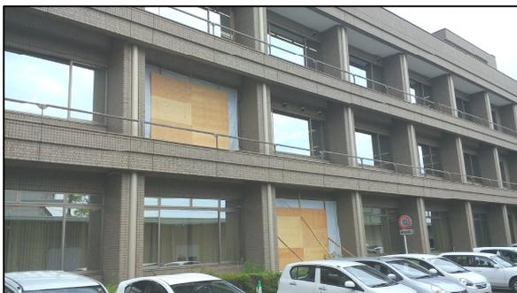
写真3 窓ガラスの破損(宇城市松橋町大野)
