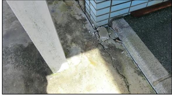
写真 20 施設コンクリートに亀裂 (植木町岩野)
