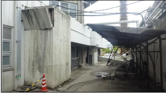
写真1 コンクリート壁の損壊(宇土市浦田町)
