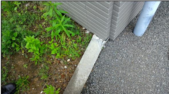
写真6 縁石の破損(宇城市豊野町糸石)
