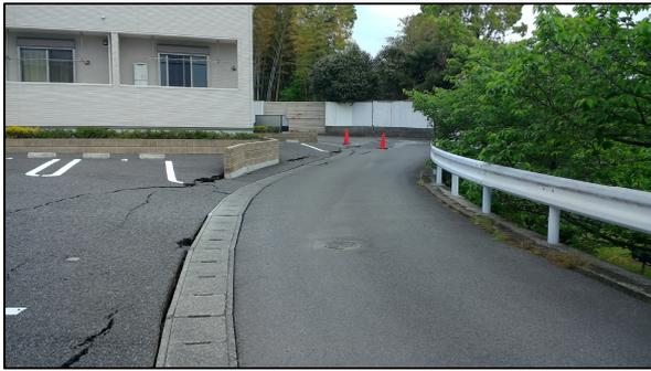
写真5 道路にできた亀裂(宇城市松橋町大野)
