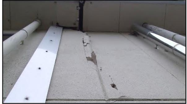
写真2 庁舎外壁の亀裂
