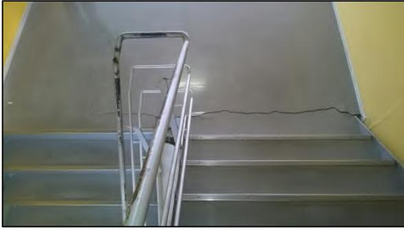
写真5 建物階段に亀裂
