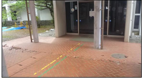
写真2 地面(レンガ)の亀裂(宇土市浦田町)
