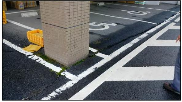
写真 15 歩道の亀裂(熊本市南区富合町清藤)
