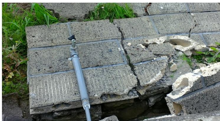
写真 1 倒壊したブロック塀と破損した水道管
