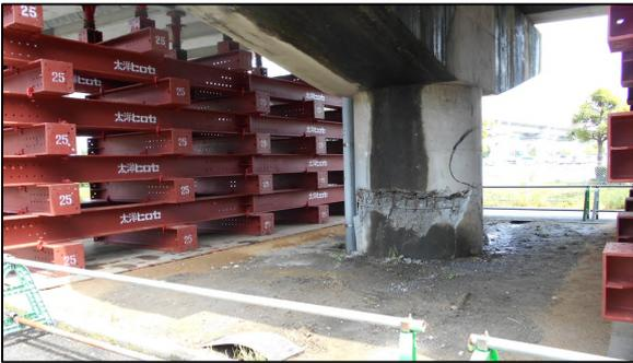
写真5 橋脚の破損(宇土市旭町:宇土市提供)
