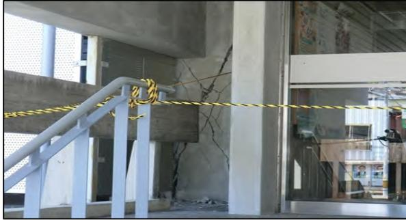
写真1 役場庁舎の壁の亀裂（大津町大津）
