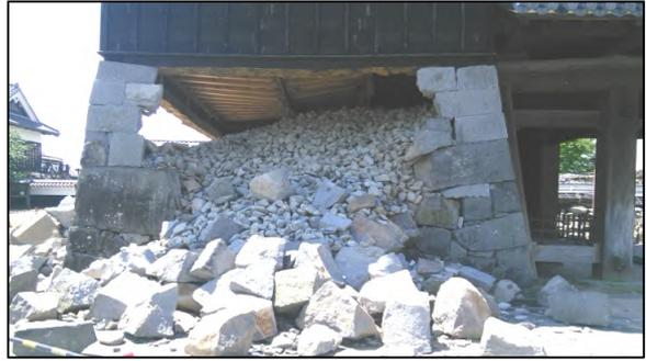
写真2 熊本城石垣の損壊(熊本市中央区本丸)
