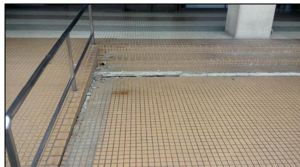
写真 18 支所の歩道陥没
