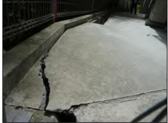
写真 2 役場 1 階駐車場一角の側溝に剥離、ひび割れ
