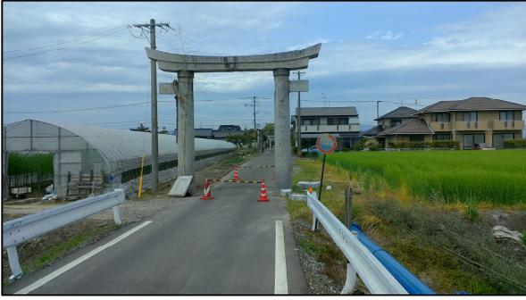
写真1 鳥居破損
