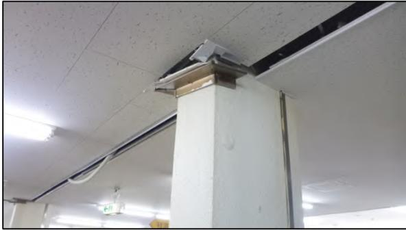
写真1 庁舎天井部材の剥離
