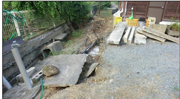
写真9 地面の陥没 (宇城市豊野町下郷)
