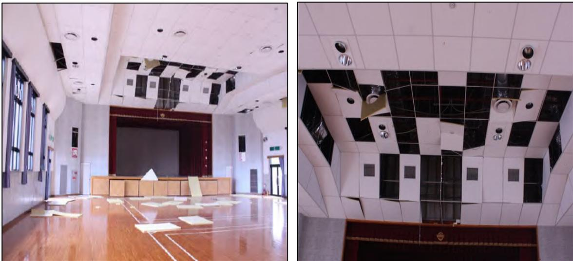
写真 2 一部分がはがれ落ちた文化施設の天井のパネル（南島原市提供）
