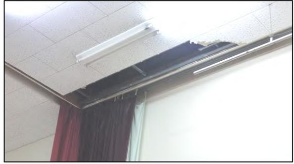
写真5 天井一部破損(菊池市泗水町豊水)
