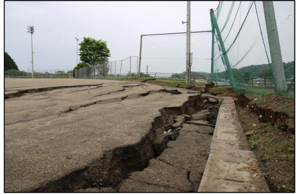
写真2 旭志市営グラウンドの地面に発生した亀裂
