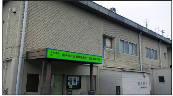
写真 13 外壁の亀裂
