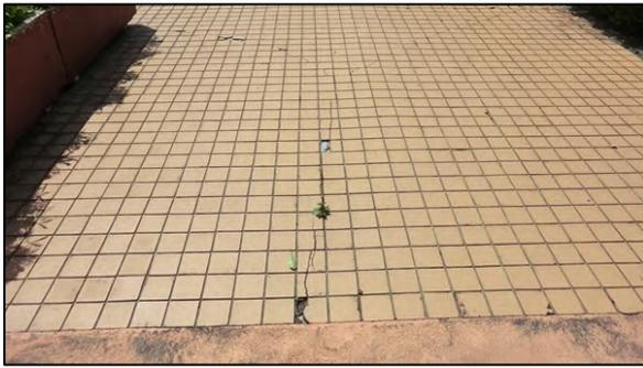
写真3 歩道に発生した亀裂(菊池市巨)
