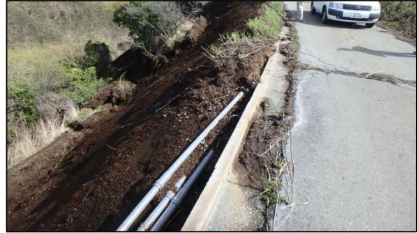
写真9 道路法面崩落(阿蘇市)
