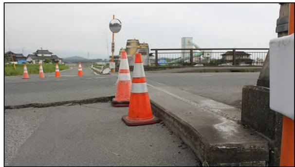
写真 16 道路の陥没(橋との段差、嘉島町北甘木)
