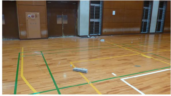
写真6 スポーツ施設天井部材落下
