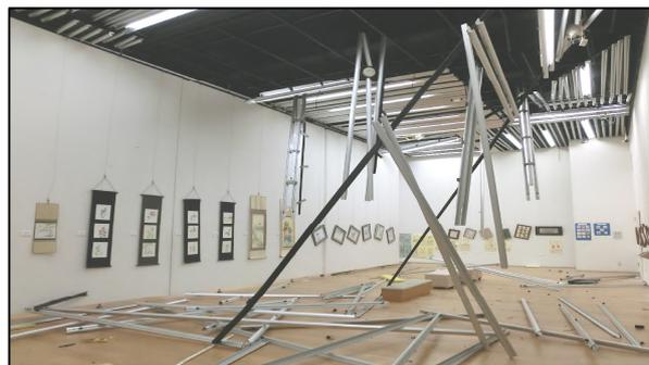
写真 20 天井構造物の落下状況
