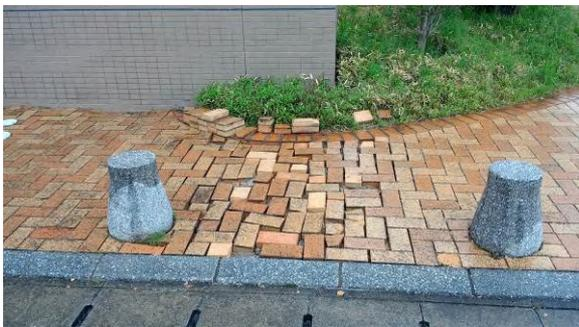
写真 18 歩道の亀裂及び湾曲(熊本市南区富合町清藤)
