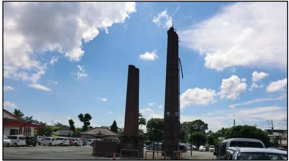
写真7 煙突一部破損(菊池市泗水町豊水)
