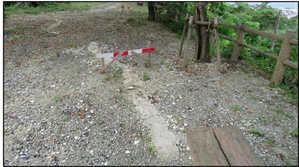
写真8 地面のひび割れ
