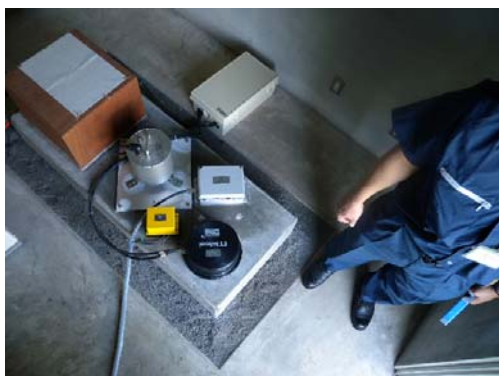
震度計の外観状況
