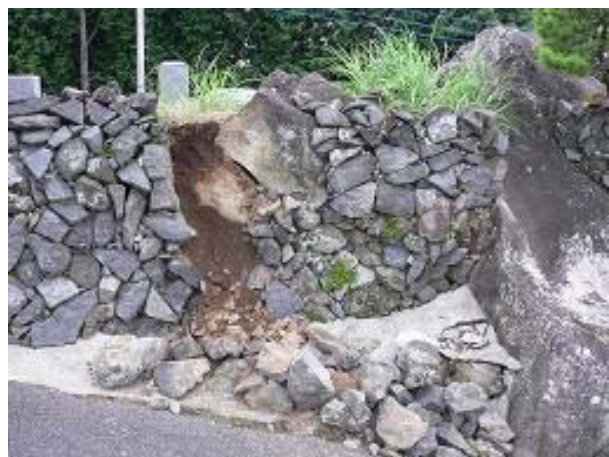
震度計から約 5 km 離れた寺社の石垣の崩落の状況
