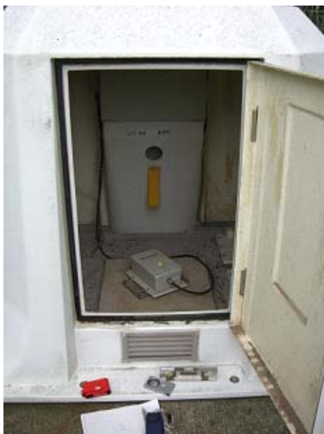
震度計の設置状況
