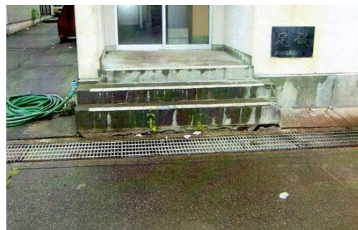
建物に生じた段差の状況
