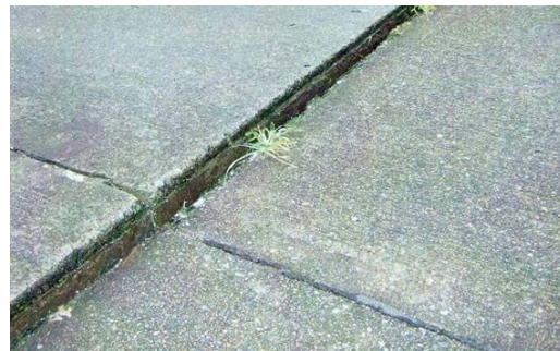
漁港内に生じた段差の状況
