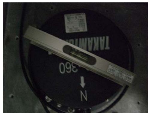
震度計設置の状況
