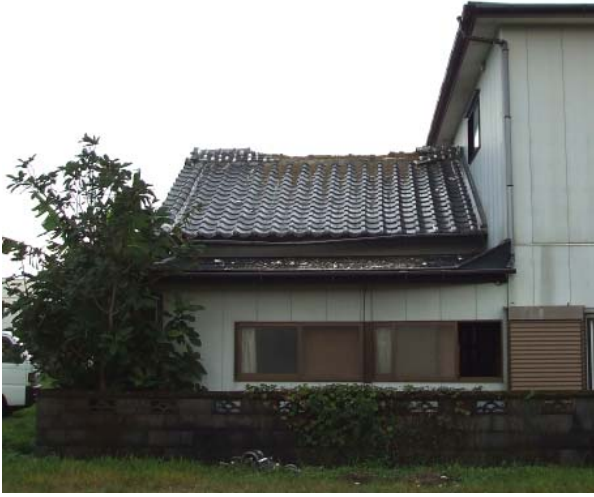
①木造家屋東の 1 階部分の屋根瓦被害
