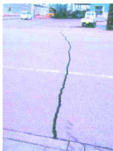
写真②焼津港の岸壁の亀裂
