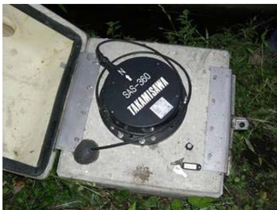
震度計の設置状況
