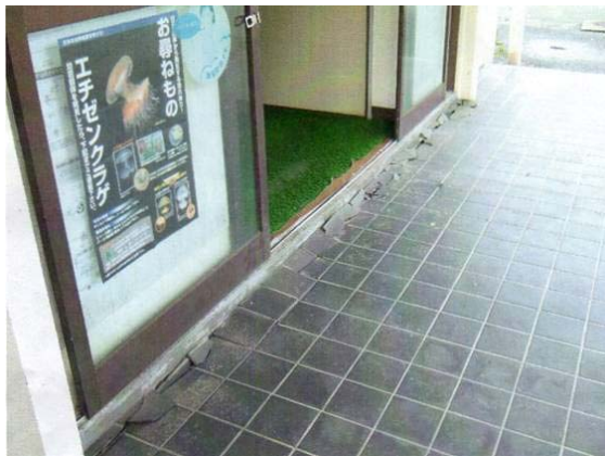
建物に生じた亀裂の状況
