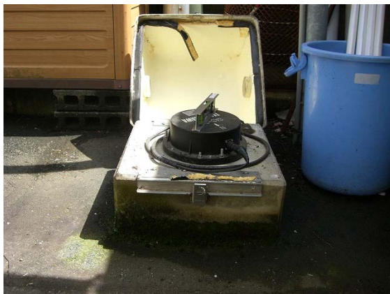
震度計設置の状況
