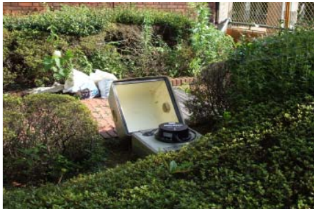
震度計の外観状況
