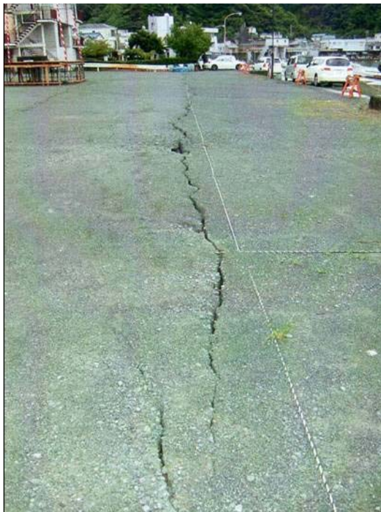
漁港内に生じた亀裂の状況
