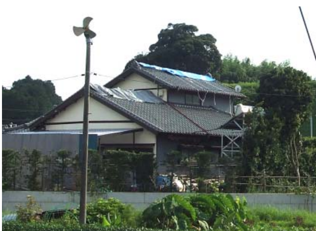
①木造家屋 2 階建ての屋根瓦被害
