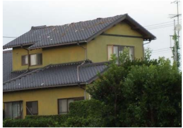
②木造家屋 2 階大屋根の瓦被害
