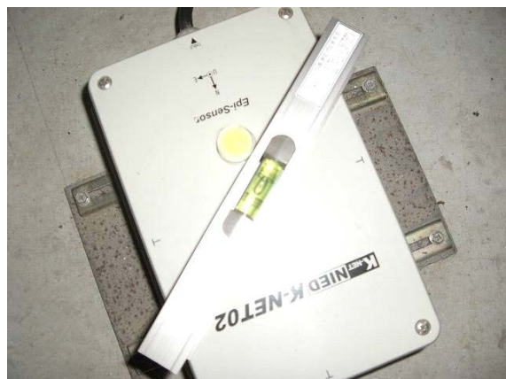
震度計の設置状況
