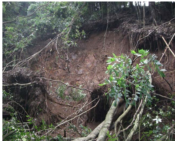
土砂崩れの規模（高さ 15m、幅 15m）
