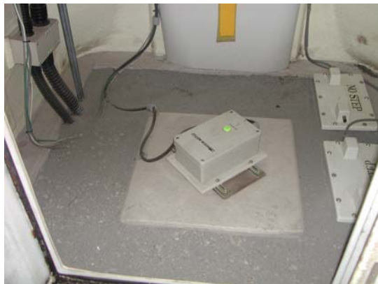
震度計設置の状況
