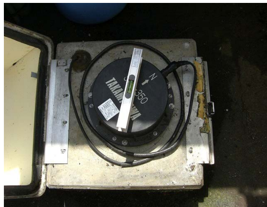
震度計設置の状況
