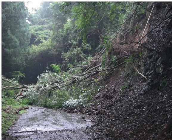
林道法面による土砂崩れの状況
