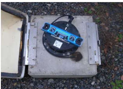
震度計の設置状況
