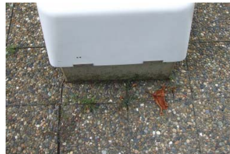
震度計の基礎台状況
