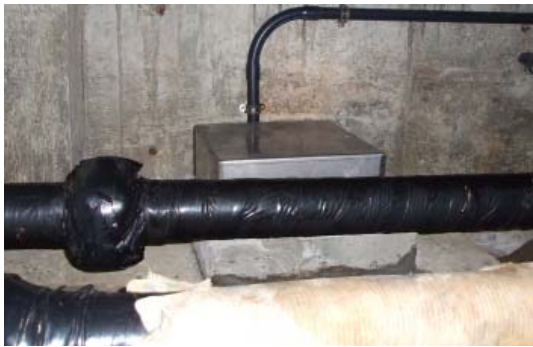
震度計の外観状況
