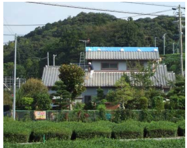
②木造家屋 2 階大屋根部分の屋根瓦
