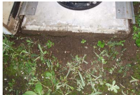
震度計の基礎台状況
