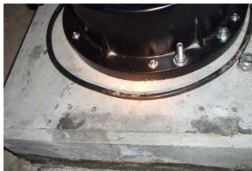
震度計の設置状況
