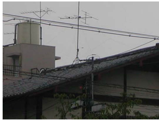
②の住家屋根瓦のずれ
