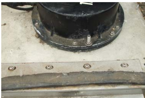
震度計の設置状況
