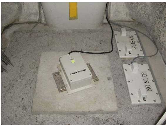
震度計の設置状況
