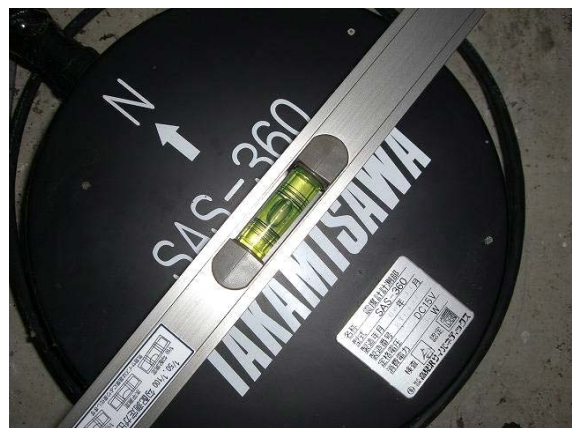
震度計の設置状況
