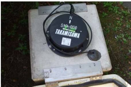
震度計の設置状況
