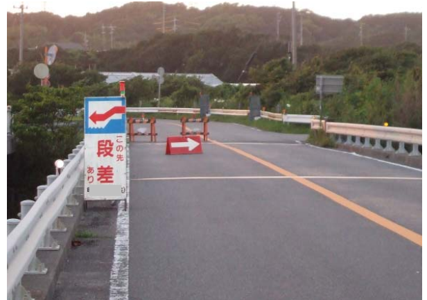
②交通規制の様子（東側から）
