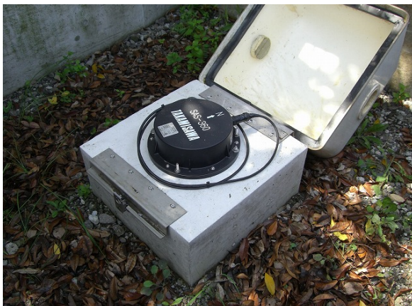
震度計設置の状況
