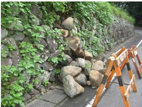
3-3 石垣の崩落状況
