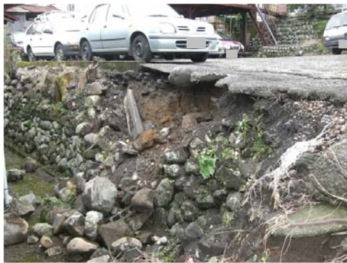
3-1 石垣の崩落状況
