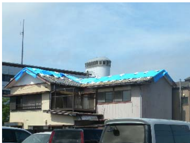
①ブルーシートをかけて屋根瓦の損傷を保護した住家
