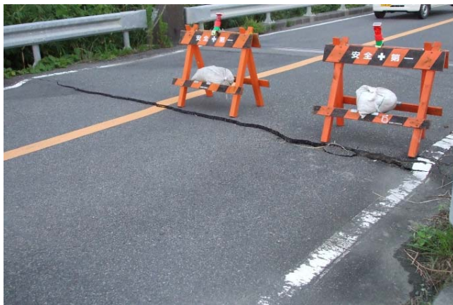
①橋梁西詰めでの段差状況
