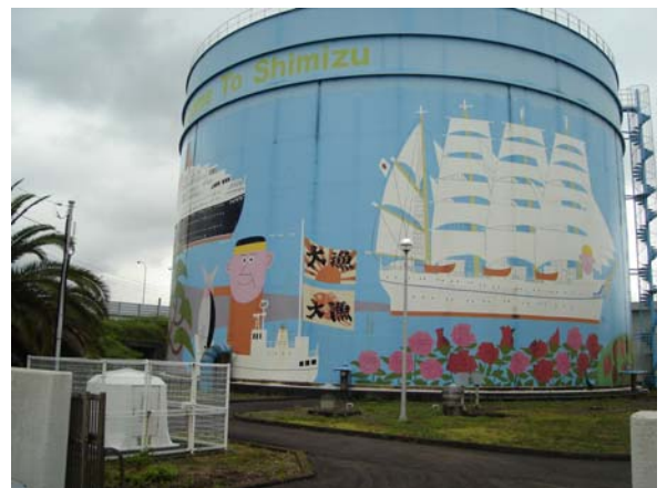
震度計設置場所（■の箇所：清水庵原配水場）
