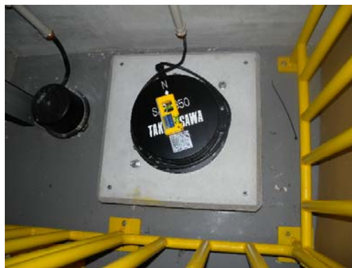
震度計の設置状況
