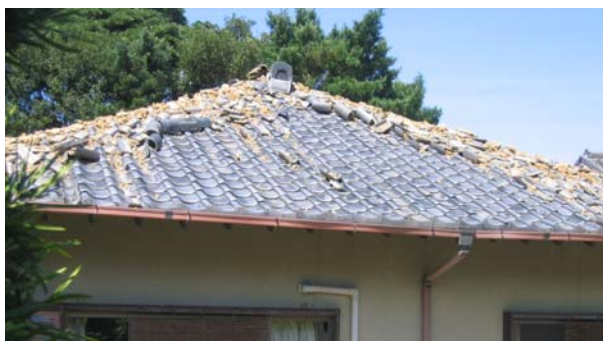
写真①住家瓦の損壊
