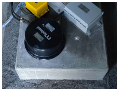
震度計の設置状況
