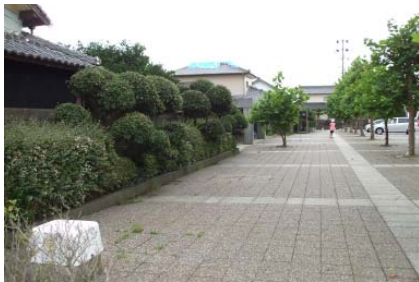
震度計の外観状況
