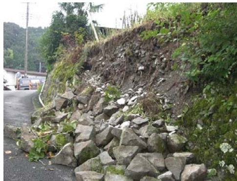
3-2 石垣の崩落状況
