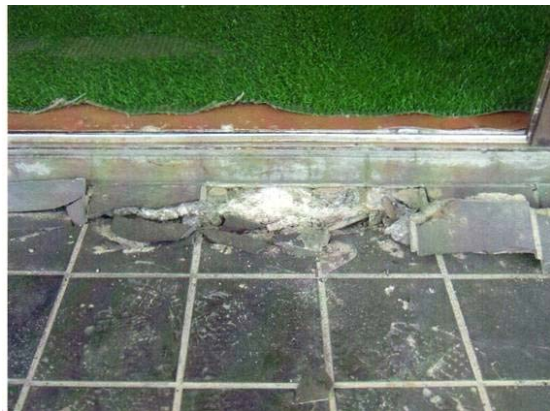
建物に生じた亀裂の状況
