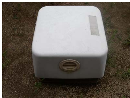
震度計の設置状況
