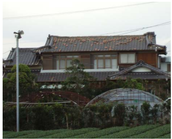
②木造家屋 2 階大屋根の瓦被害
