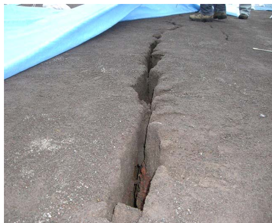
グラウンドの最大亀裂
