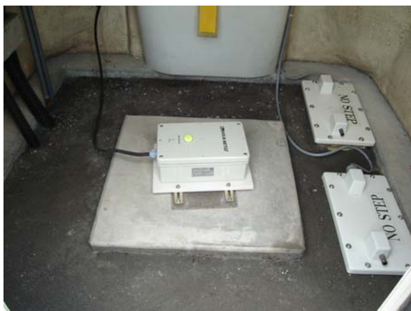
震度計設置の状況
