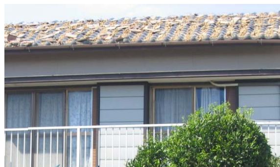
写真②住家瓦の損壊
