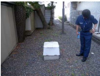
震度計の外観状況
