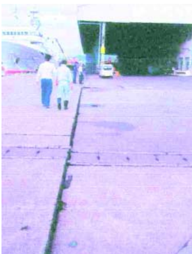
写真①焼津港の岸壁の段差
