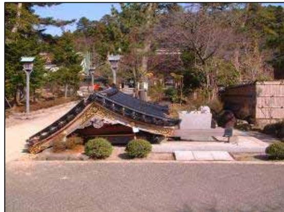
写真 (No.6) 柱部分が折れ倒壊した寺院の建物
