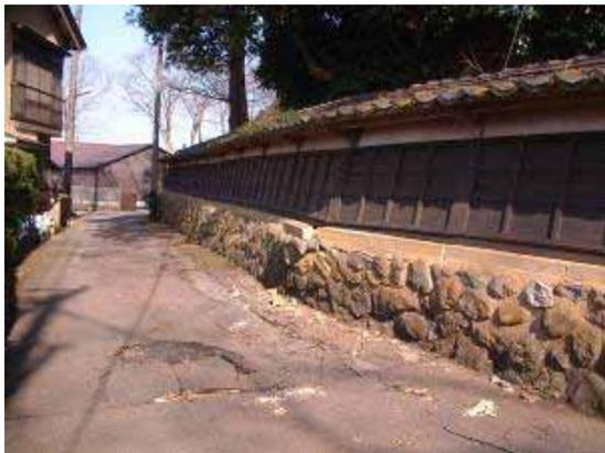
写真 (No.7) 塀の基礎部分の崩壊
