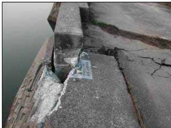
写真 (No.2) コンクリート舗装の落下
