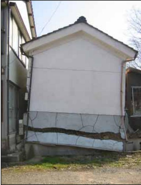
写真 (No.3) 一部崩壊した土蔵
