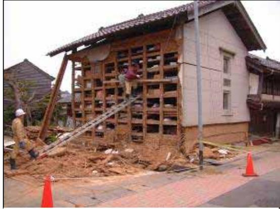
写真 (No.2) 土蔵の壁の崩落
