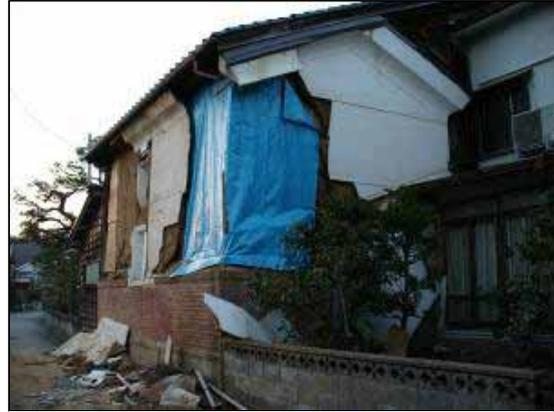
写真 (No.6) 土蔵の壁の崩壊
