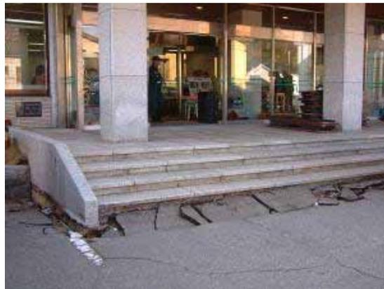
写真 (No.8) 輪島市役所門前総合支所玄関前の舗装部分が下がり亀裂が生じている。
