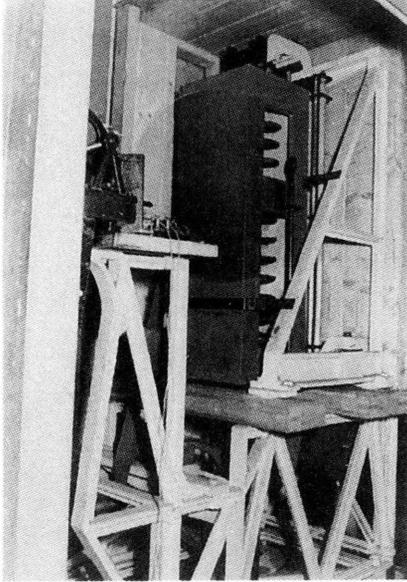
第24図 ウィーヘルト地震計上下動
