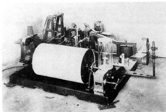
第28図 50型機械式1倍強震計
