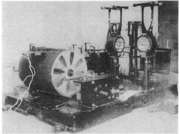
第19図 中央気象台式（新式）簡単微動計
