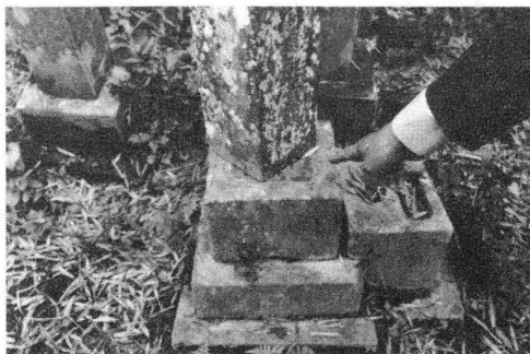
写真1 図2のI付近の墓石 地震動で中心が動いた古い墓石。 なお、周辺の墓石はほとんど動いたり、倒れたりしていたと云うことであるが、現地調査時には、復元されていた。墓石の回転方向は反時計回りのものが多く見られた。
