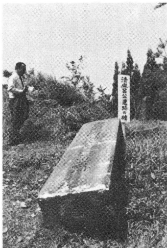
写真2 図2のII付近(犬飼地区)の和気清 麻呂公遺跡の碑 碑石は台座から2回転して南西方向 に倒れている。また築石に接触して 弾き飛ばしている。 碑の寸法 200×60×35cm
