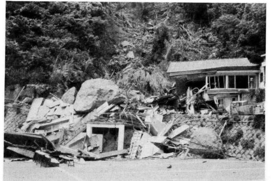
Photo. 6 石廊崎波止場付近の落石による家屋の全壊
