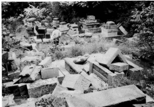
Photo. 21 下小野の墓地の転倒破壊した墓石
