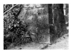
Photo. 7. 石垣のき裂 (のちに崩壊) (野伏)
