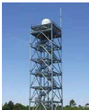
現在研究に活用している フェーズドアレイレーダー
