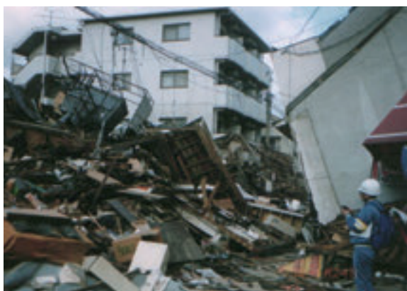
倒壊した家屋(神戸市)
