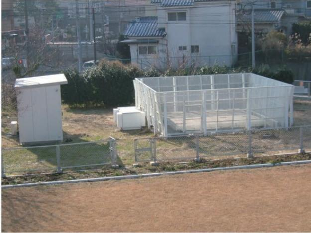
水戸観測局の全景。白い四角のフェンス内の地面にアンテナが設置されています。
