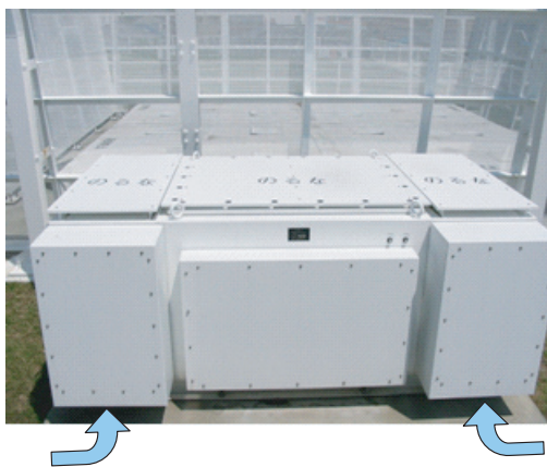
第2.7図 勝浦観測局モジュール収容架空気取入口の改修状況 矢印は空気の流れ（左：改修前は空気取入口が下、右：改修後は空気取入口が上方）。
