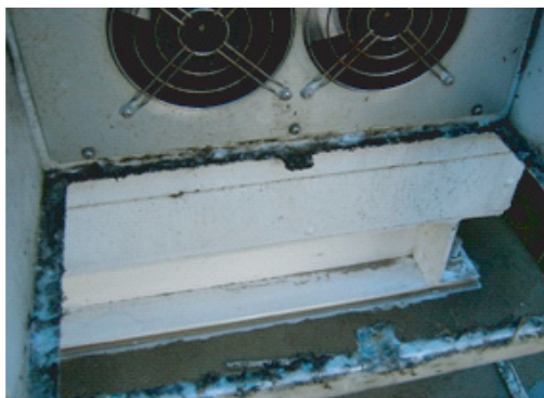
第2.6図 勝浦観測局モジュール収容架空気取入口の状況 （左：外枠に付着した白い腐食物、右：腐食により崩れてしまったフィルター押さえ枠）
